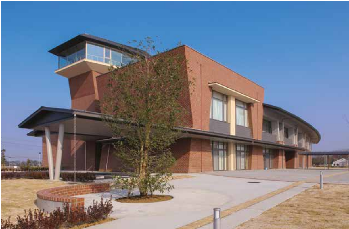
▲埼玉県川島町庁舎
